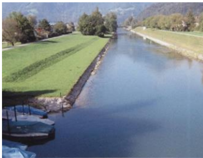
Links der 5 km lange, seit 1811 die Wasser der Linth ab Mollis/Näfels in den Walensee umleitende Escherkanal. Rechts der 17 km lange Linthkanal, der seit 1823 die Wasser von Linth, Maag und Seez sowie weiterer kleinerer Walensee-Bergbäche aus dem als Auffangs- und Ausgleichsbecken genutzten Walensee von Weesen bis Schmerikon bzw. Schloss Grynau in den Oberen Zürichsee leitet. (Fotos aus dem Jahre 2005.) Im rechten Bild ist die Doppel-Trapezform des Kanalprofils gut ersichtlich.
