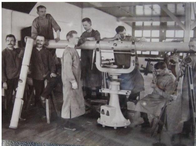
Doppelbild-Telemeter-Montage bei Zeiss in Jena, ca. 1907.
