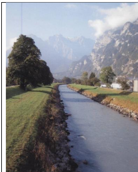
Links der 5 km lange, seit 1811 die Wasser der Linth ab Mollis/Näfels in den Walensee umleitende Escherkanal. Rechts der 17 km lange Linthkanal, der seit 1823 die Wasser von Linth, Maag und Seez sowie weiterer kleinerer Walensee-Bergbäche aus dem als Auffangs- und Ausgleichsbecken genutzten Walensee von Weesen bis Schmerikon bzw. Schloss Grynau in den Oberen Zürichsee leitet. (Fotos aus dem Jahre 2005.) Im rechten Bild ist die Doppel-Trapezform des Kanalprofils gut ersichtlich.
