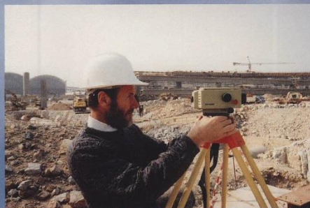
Bau des Hongkong-Flughafens Lap-Chek-Kok 1996 mit Digitalnivellier Wild DNA2000.
