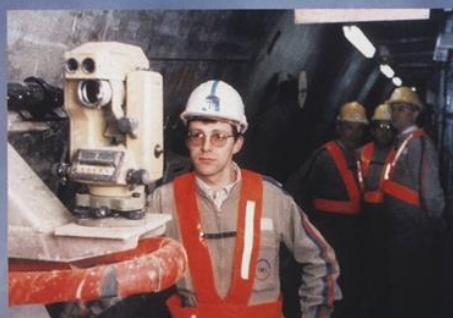
Oben: Richtungskontrolle der Vortriebsmaschine im Eurotunnel 1987 mit Elektroniktheodolit Wild T1600 und Infrarotlaser-Distanzmesser Wild DI3 aus Heerbrugg.
