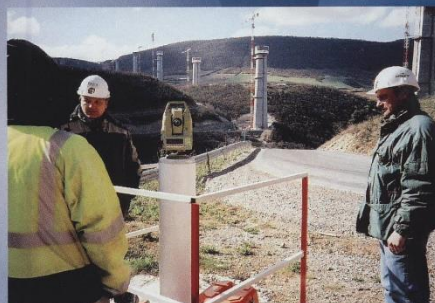
Bau des Viaduc de Millau 2003 mit Lasertheodolit.
